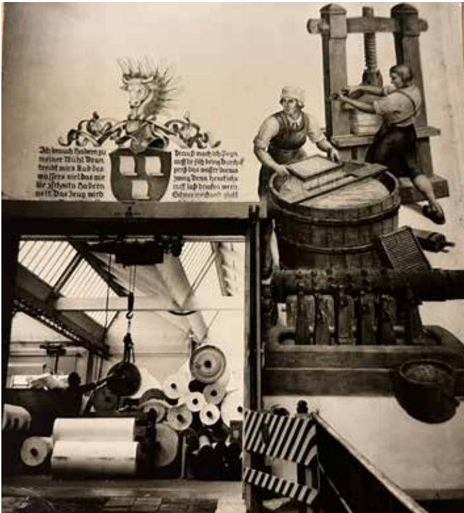
In den Fabrikationshallen der einstigen Firma Schoeller & Hoesch erinnert noch heute ein historisches Wandgemälde an die Papierherstellung. Foto: Eugen Kurz
